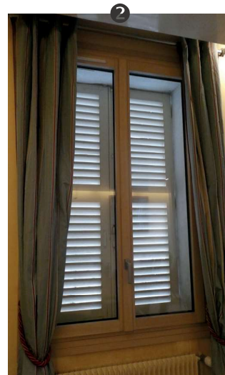
1 Fenêtres de la mairie avant et après travaux.
